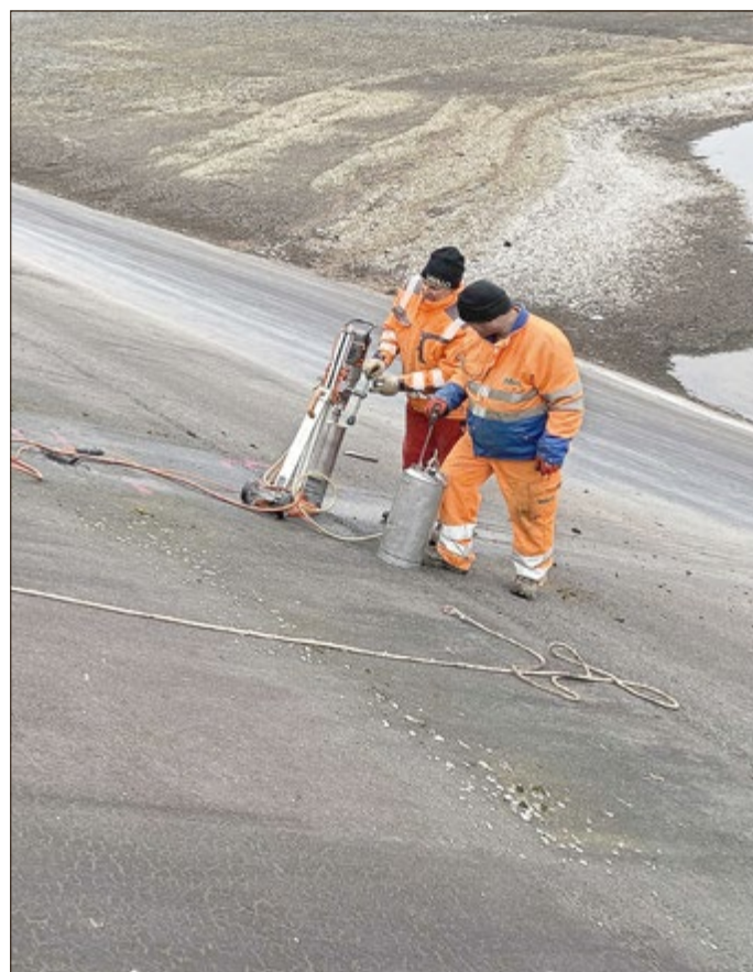
Entnahme der Bohrkern am HRB Ratscher für die spätere Beprobung. Foto: Thüringer Fernwasserversorgung, Jochen Mehl
